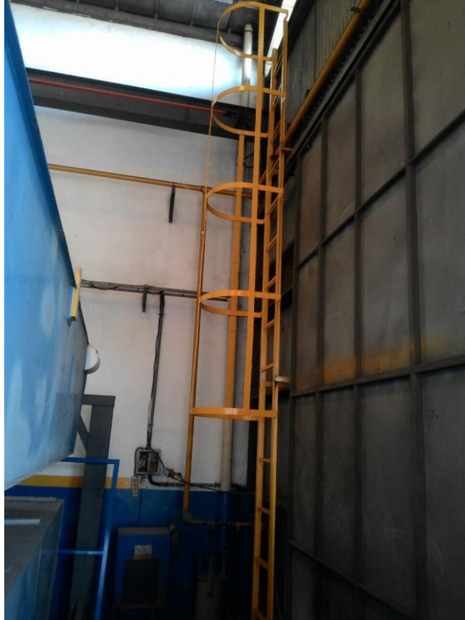
Gambar 5.6 Hasil Pembuatan Tangga
