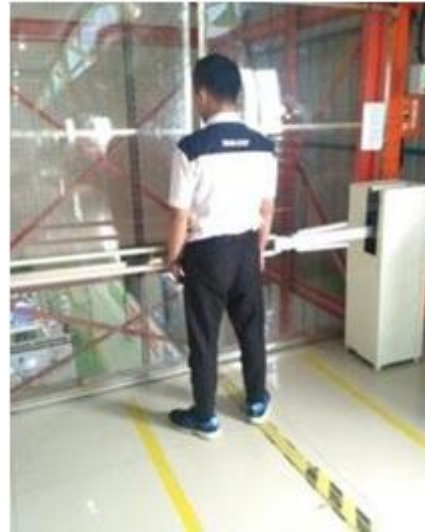
Gambar 4.3 Palang pintu lift lantai 2 (simulasi karyawan)
